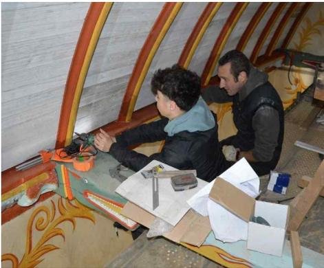
L'entreprise d'électricité Lautech installe le câblage électrique pour la pose du système d'éclairage et l'installation du vidéo – projecteur.
